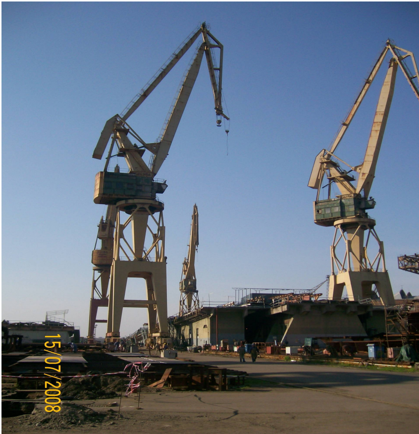
Grúas de una de las tres gradas que posee el ARS:15-7-08
